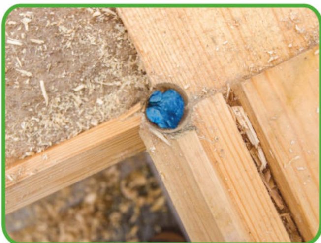
Запененный вертикальный канал
