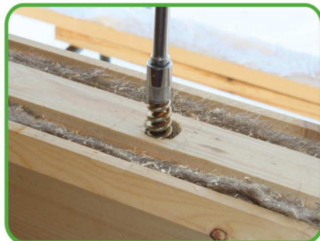
Вворачивание межвенцового крепежа
