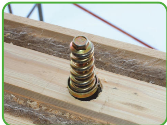
Расстановка межвенцового крепежа
