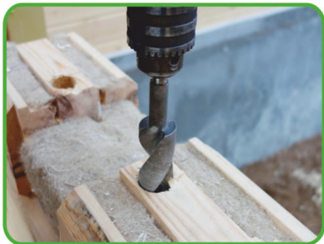
Сверление отверстия под установку межвенцового крепежа «Tedwood»
