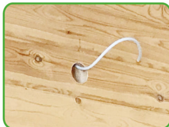
Комбинация отверстий вертикального канала и отверстия подрозетника
