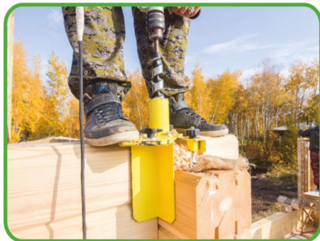
Оснастка «Теплый угол» в работе
