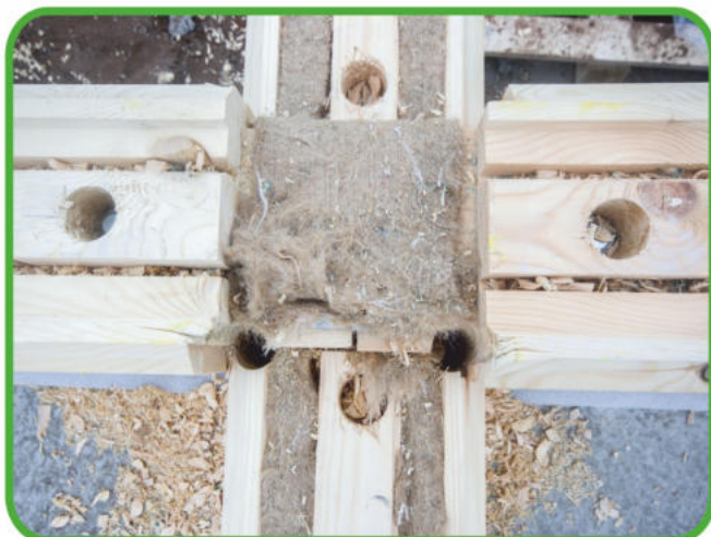
Вертикальные каналы в замковом соединении
