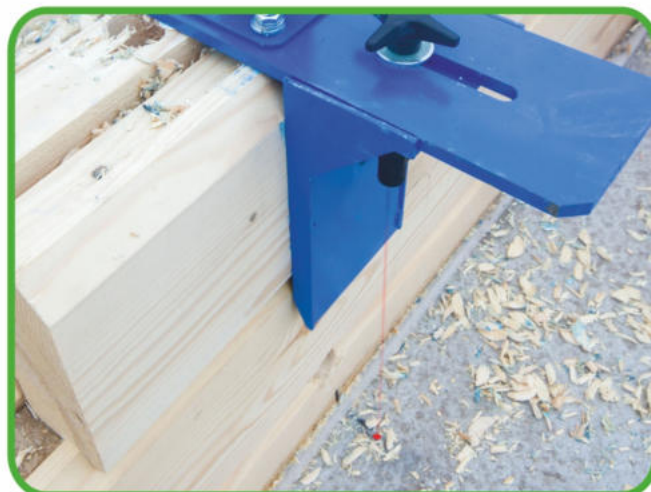
Позиционирование оснастки по отношению к разметке скрытого канала
