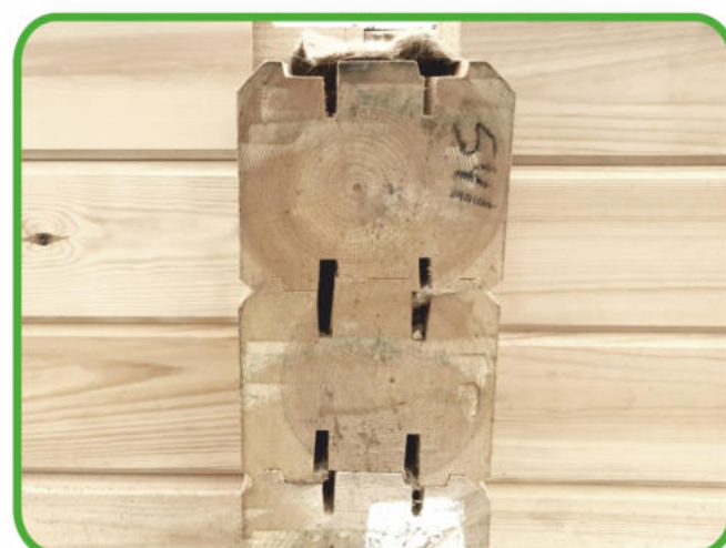
100% устранение зазора в пазо-гребневом соединении деталей
